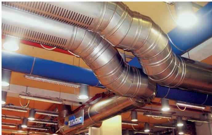
**La ventilazione degli ambienti in caso di incendio può essere realizzata con un impianto di estrazione fumi canalizzato.**
