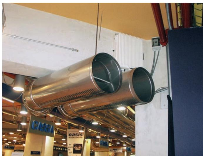
**Le canalizzazioni circolari per l'estrazione dei fumi sono dotate di serrande comandate dal sistema di rivelazione fumi.**
