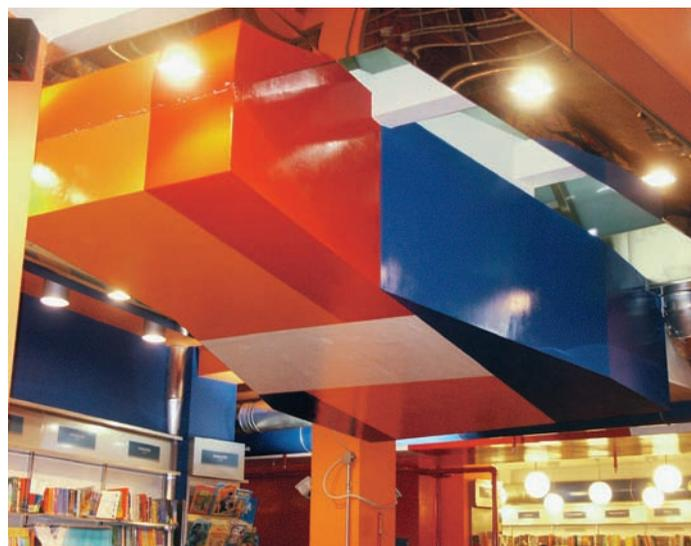
**I plenum a sezione rettangolare alla base dei montanti sono rivestiti con materiali REI 120 e verniciati.**
