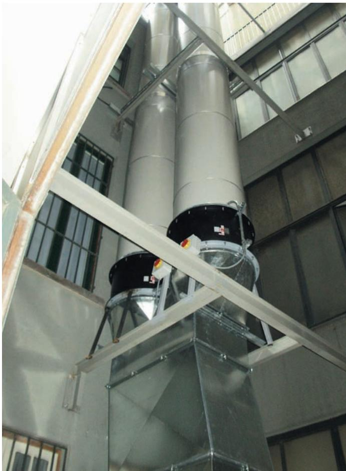
**I montanti di evacuazione fumi sono dotati di ventilatori di estrazione che garantiscono un funzionamento continuo per due ore consecutive a 400 °C.**
