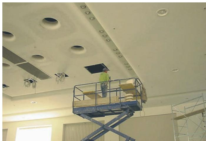
**Fig. 1- L'impianto sprinkler in fase di realizzazione nell'ambiente a grande altezza.**
