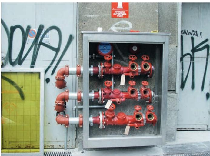
**Fig. 3 - Il gruppo attacco motopompa VVF è posizionato all'esterno in posizione accessibile.**
