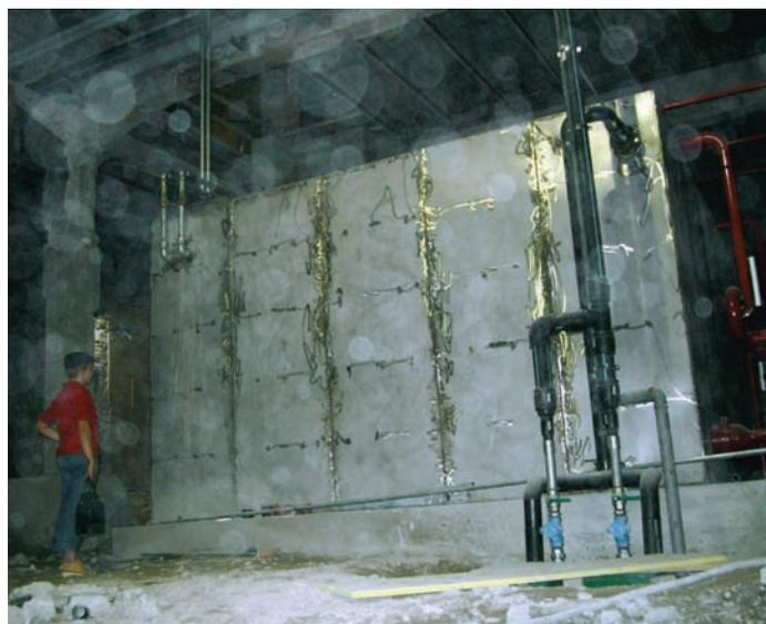
**Fig. 4 - La vasca antincendio con capacità di 90 m<sup>3</sup> è realizzata in acciaio inox.**
