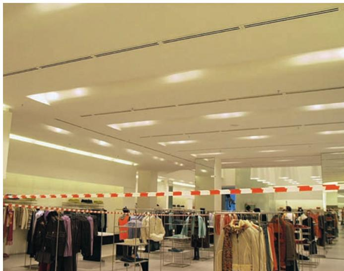
**Fig. 2 – L'impianto sprinkler integrato nel controsoffitto della zona di vendita.**
